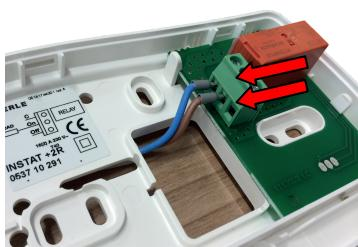
Schließen Sie nun das 2-polige Kabel an den Positionen 1 und 2 der Klemmleiste an.
